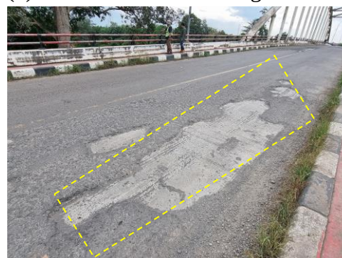
(d) Flexible Pavement condition of bridge
